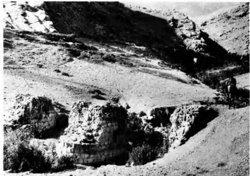
(d) Pul-i-Darre-yi-Shahr, Saimarre Valley. Sasanian(?) Bridge.
