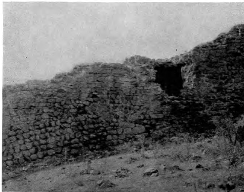
FIG. 67.—NIKSAR. THE CITADEL WALL
