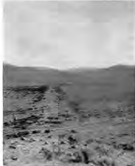
FIG. 131.—BULUMASHLÜ. THE EMBANKMENT
